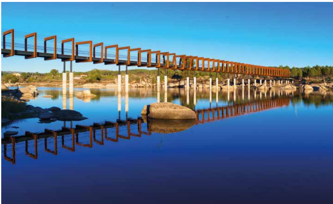
Obra: Ponte Pedonal // Localidade: Ferreirim - Sernancelhe // Produtos: Primário SR e Esmalte SR com acabamento em Aço Corten
