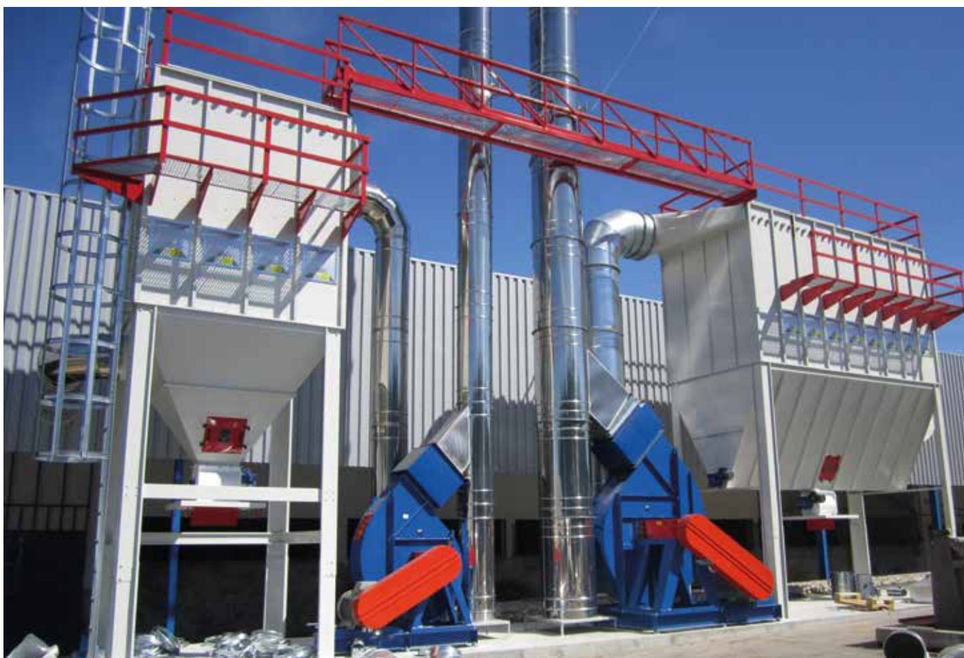
Obra: Instalações Ventasel // Localidade: Ribeirão - Braga // Produtos: Primário Anticorrosivo, Esmalte Acrílico HB GAL, Esmalte Policril MB
