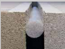
Junta de dilatação
