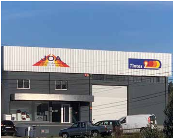
Exterior do novo armazém
