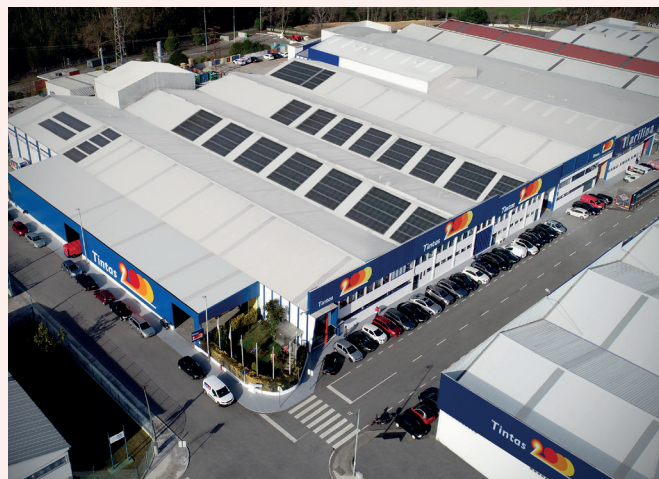
Vista aérea da sede do Grupo Tintas 2000 com os painéis fotovoltaicos
