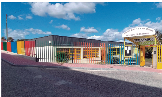
Exterior da EB1/JI de Casas
