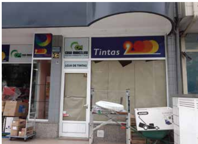
Exterior da Loja em remodelação
