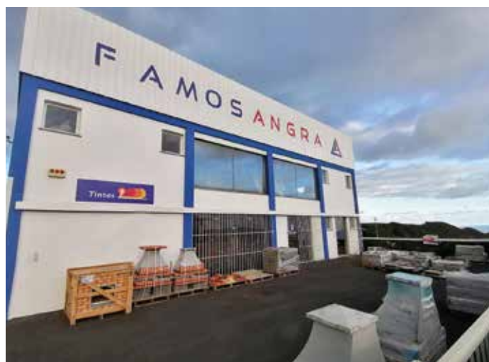
Exterior do armazém
