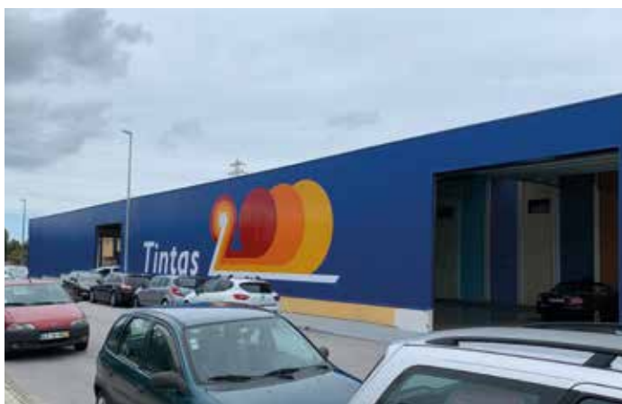
Vedação externa da área de expedição do APA da Tintas 2000
