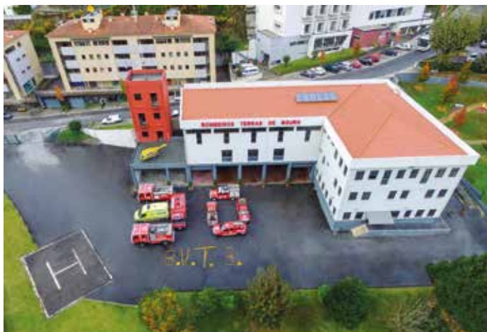
Sede dos Bombeiros Voluntários de Terras de Bouro
