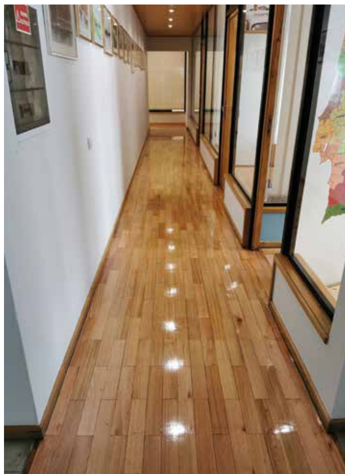
Envernizamento do pavimento de madeira
