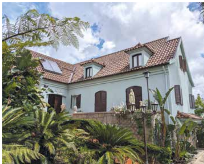
Obra: Moradia Familiar // Localidade: Vermoim - Vila Nova de Famalicão // Produtos: Primário Lamurite Aquoso + Crepimil Extra T12 NCS S 1510-G // Ciente: Hélder M. S. Santos, Unipessoal. Lda. // Comercial: Henrique Costa
