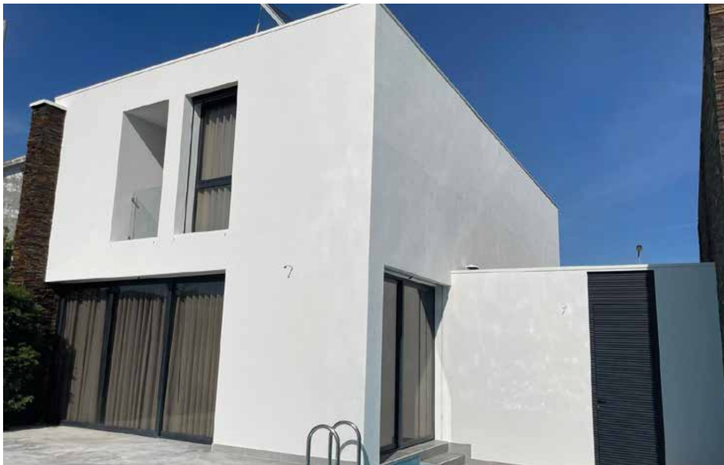
Obra: Moradia Familiar // Localidade: Barcelos // Produtos: Betomil + Crepimil Extra + Marina // Cliente: MC Manuel Cavalheiro // Comercial: João Teixeira
