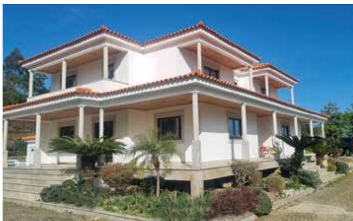
Obra: Moradia Familiar // Localidade: Barcelos // Produtos: Fachada: Primário Pliomil + Plas Super + Esmalte PU Madeiras / Interior: Primário Pliomil Aquoso + Anti Manchas + Plasmate / Madeiras: Subcapa PU TIX + Lacamil Plus Mate. // Ciente: Luís Diogo Barros // Comercial: Daniel Gonçalves
