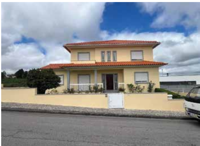
Obra: Moradia Familiar // Localidade: Quintela de Azurara - Mangualde // Produtos: Telhados: Hidrofugante Aquoso Telhas / Fachada: Primário Isolina + Lináqua // Ciente: Fernando Andrade Ribeiro // Comercial: Luís Almeida
