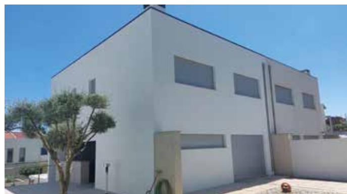
Obra: Moradia Familiar // Localidade: Vila Nova de Famalicão // Produtos: Sistema ThermInnov // Cliente: José Miguel Veloso Unipessoal, Lda. // Comercial: Henrique Costa
