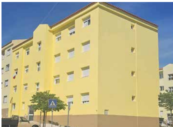
Obra: Prédio Habitacional // Localidade: Cascais // Produtos: Primário Isolina + Plastolina // Cliente: Planeta Salteado // Comercial: Luís Alves
