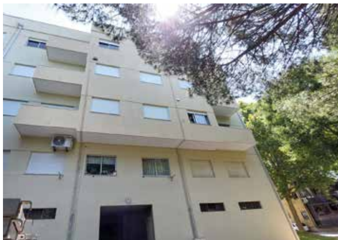
Obra: Prédio Habitacional // Localidade: Parretas - Braga // Produtos: Sistema ThermInnov + Plomil Aquoso NG NCS 1005-Y10R // Cliente: José Miguel Veloso Unipessoal, Lda. // Comercial: Henrique Costa
