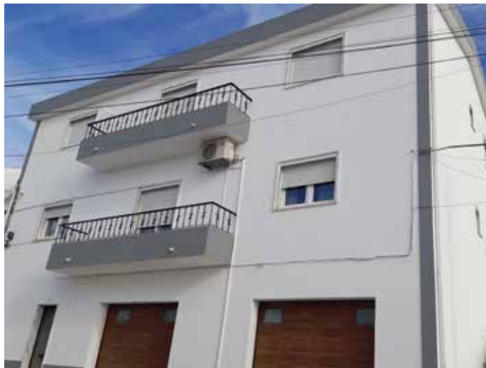
Obra: Moradia Familiar // Localidade: Alcácer do Sal // Produtos: Primário Pliomil Aquoso + Plomil Aquoso NG // Cliente: Luís Duarte // Comercial: Vítor Neto
