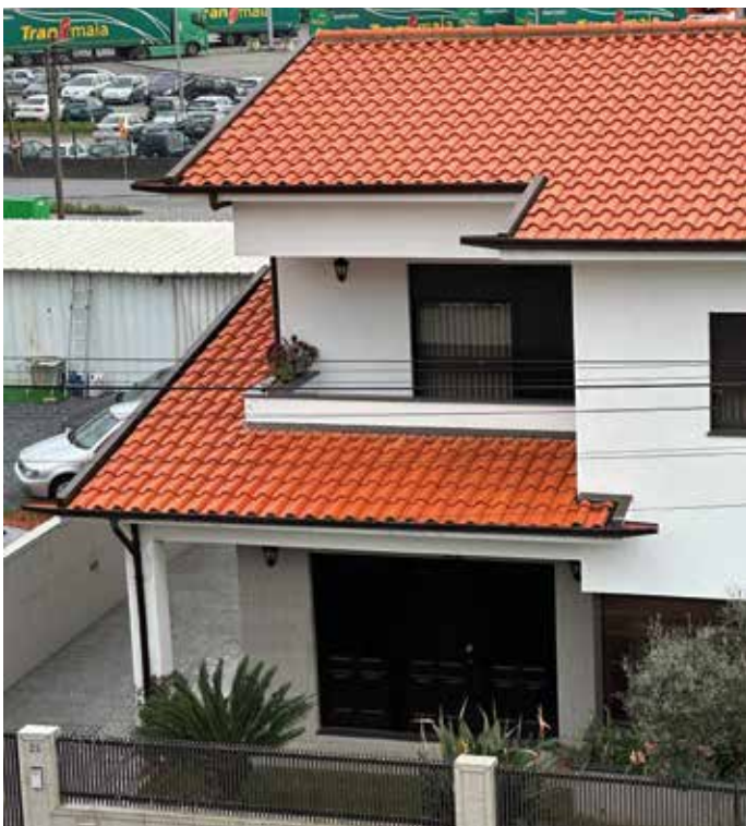
Obra: Telhado // Localidade: Vila Nova de Gaia // Produtos: Limpamil + Hidrofugante Aquoso Telhas // Ciente: Bruno Leandro Revestimentos // Comercial: Hugo Figueiredo
