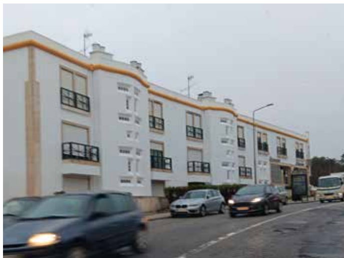
Obra: Prédio Habitacional // Localidade: Évora // Produtos: Primário Pliomil Aquoso + Plas Super // Ciente: António Manuel Dias Cambeiro // Comercial: Vitor Neto
