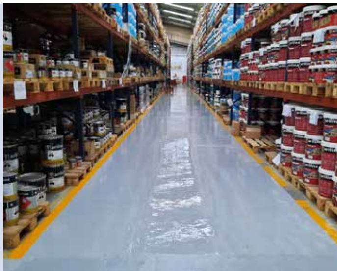
Obra: Pavimento Industrial // Localidade: Maia // Produtos: Primário EP 2Floor 15-930 + Esmalte EP 2Floor 10-910
