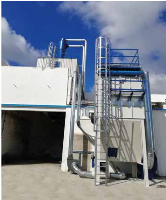
Obra: Sistema de Despoeiramento // Localidade: Açores // Produtos: Primário Policril Cinzento + Esmalte Policril M/B // Cliente: Ventasel-Ventilações e Aspiraões Serralharia Mecânica, Lda. // Comercial: Henrique Costa
