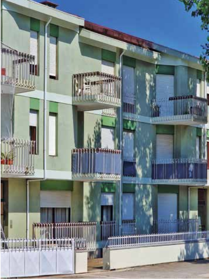
Obra: Prédio Habitacional // Localidade: Leça da Palmeira - Matosinhos // Produtos: Isolante Betonilha + Argamassa ThermInnov 2009 + Primário Isoselante + Crepimil Extra R12TD6421 Mineral // Cliente: MODOTEGOM // Aplicador: NSM PINTURAS // Comercial: Carlos Lopes
