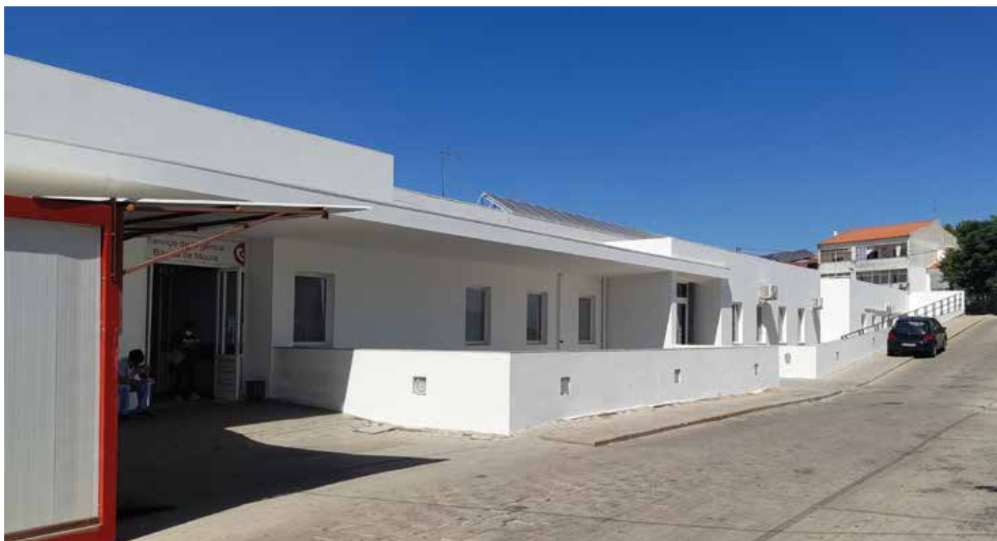
Obra: Centro de Saúde de Moura // Localidade: Moura - Beja // Produtos: Primário Pliomil Aquoso + Plas Super // Cliente: Raig // Comercial: Vitor Neto
