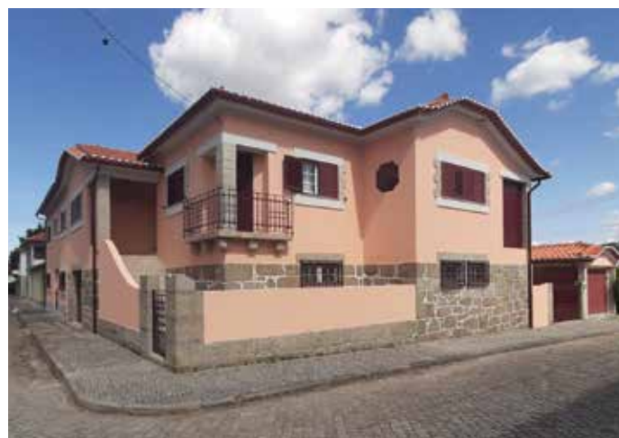
Obra: Moradia Familiar // Localidade: Tondela // Produtos: Telhado: Limpamil + Hidrofugante / Fachada: Primário Pliomil + Tinta Acrílica Pura 9G + Marina / Gradeamentos e Portões: Esmalte Ferromil + Esmalte Maital // Ciente: Carlos Alberto Coimbra Figueiredo // Comercial: Armando Almeida
