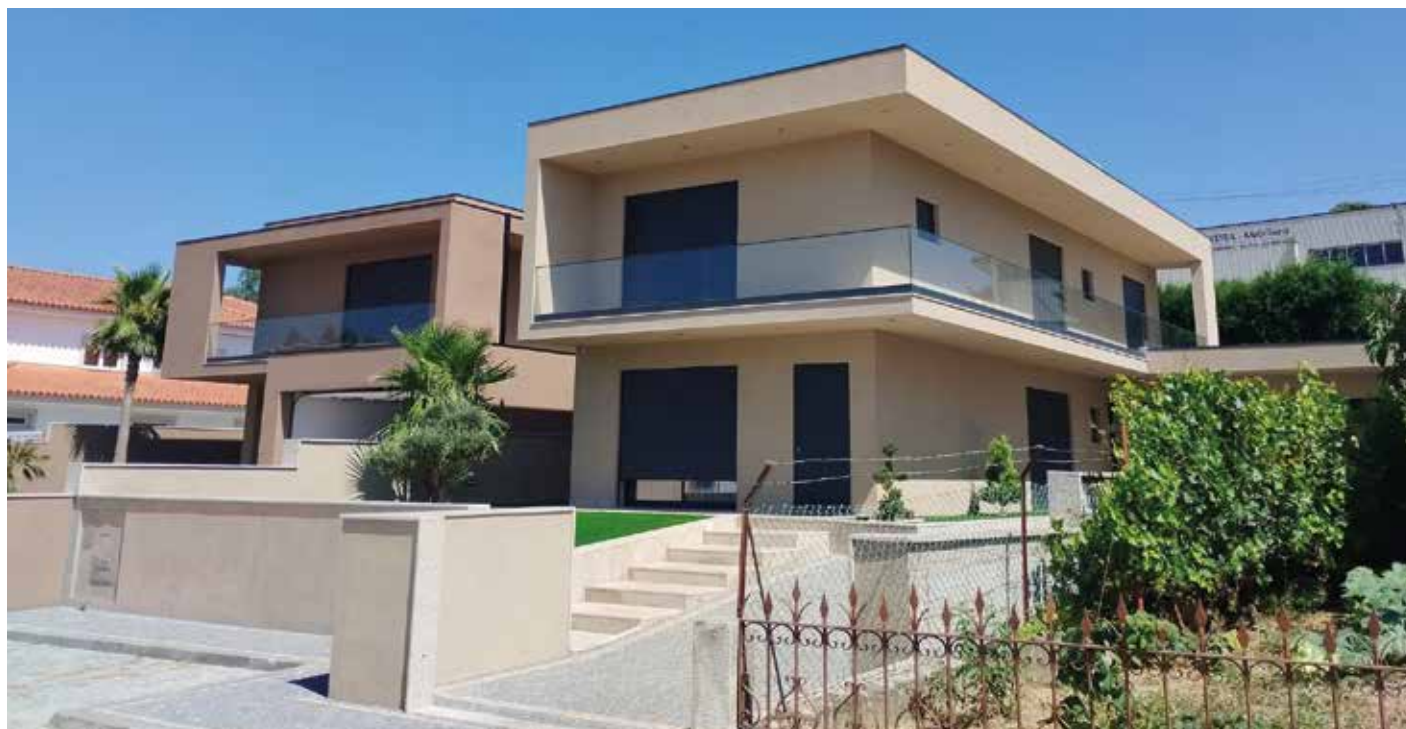
Obra: Moradias Familiares // Localidade: Paredes // Produtos: Primário Isolina + Crepimil Extra R12 // Ciente: Construção Civil Venâncio A. Pereira // Comercial: Paulo Gomes
