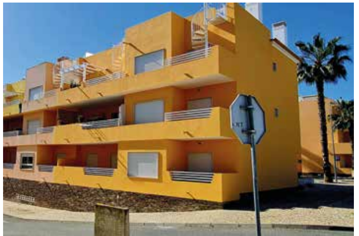
Obra: Prédio Habitacional // Localidade: Cabanas de Tavira // Produtos: Telhado: Limpamil + Hidrofugante / Fachada: Primário Isoselante + Plas Super Cliente: António Anjos & Ilídio Calfate // Comercial: João Vieira
