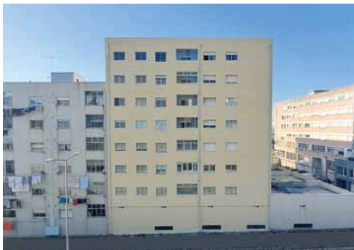
Obra: Prédio Habitacional // Localidade: Braga // Produtos: Sistema ThermInnov // Cliente: José Miguel Veloso Unipessoal, Lda. // Comercial: Henrique Costa
