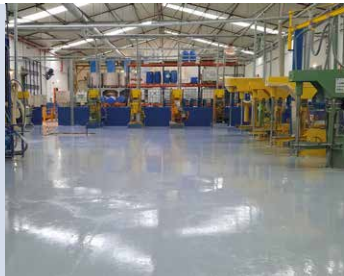
Obra: Pavimento Industrial // Localidade: Maia // Produtos: Primário EP 2Floor 15-930 + Esmalte EP 2Floor 10-910
