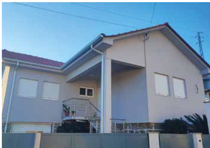
Obra: Moradia Familiar // Localidade: Calendário - Vila Nova de Famalicão Produtos: Sistema ThermInnov // Ciente: Joaquim Sá // Comercial: Henrique Costa
