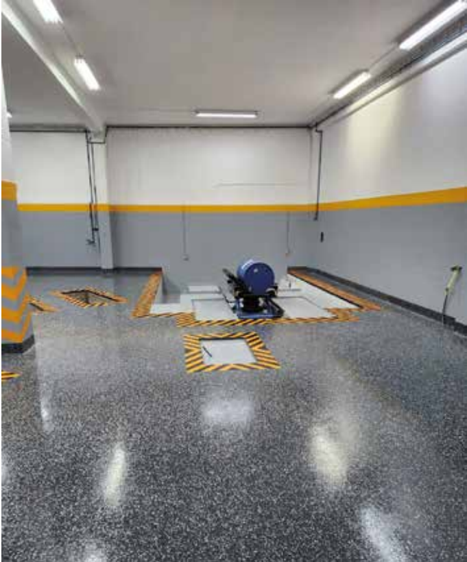
Obra: Pavimento // Localidade: Marinha Grande // Produtos: Esmalte EP 2Floor 15-910 + Esmalte PU 2Floor 10-900 (acabamento com flocos) // Cliente: Resina Best // Comercial: José Oliveira Azevedo
