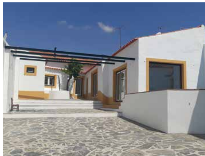
Obra: Moradia Familiar // Localidade: Monte do Trigo - Portel // Produtos: Primário Pliomil Aquoso + Plas Super // Ciente: Cláudio Rodrigues // Comercial: Vitor Neto
