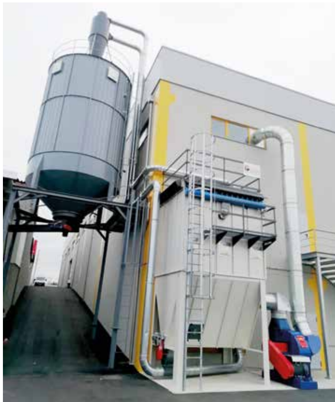
Obra: Sistema de Despoeiramento // Localidade: Oliveira do Hospital Produtos: Primário Policril Cinzento + Esmalte Policril M/B // Cliente: Ventasel-Ventilações e Aspiraões Serralharia Mecânica, Lda. // Comercial: Henrique Costa
