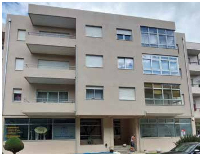
Obra: Prédio Habitacional // Localidade: Póvoa de Varzim // Produtos: Sistema ThermInnov // Cliente: José Miguel Veloso Unipessoal, Lda. // Comercial: Henrique Costa
