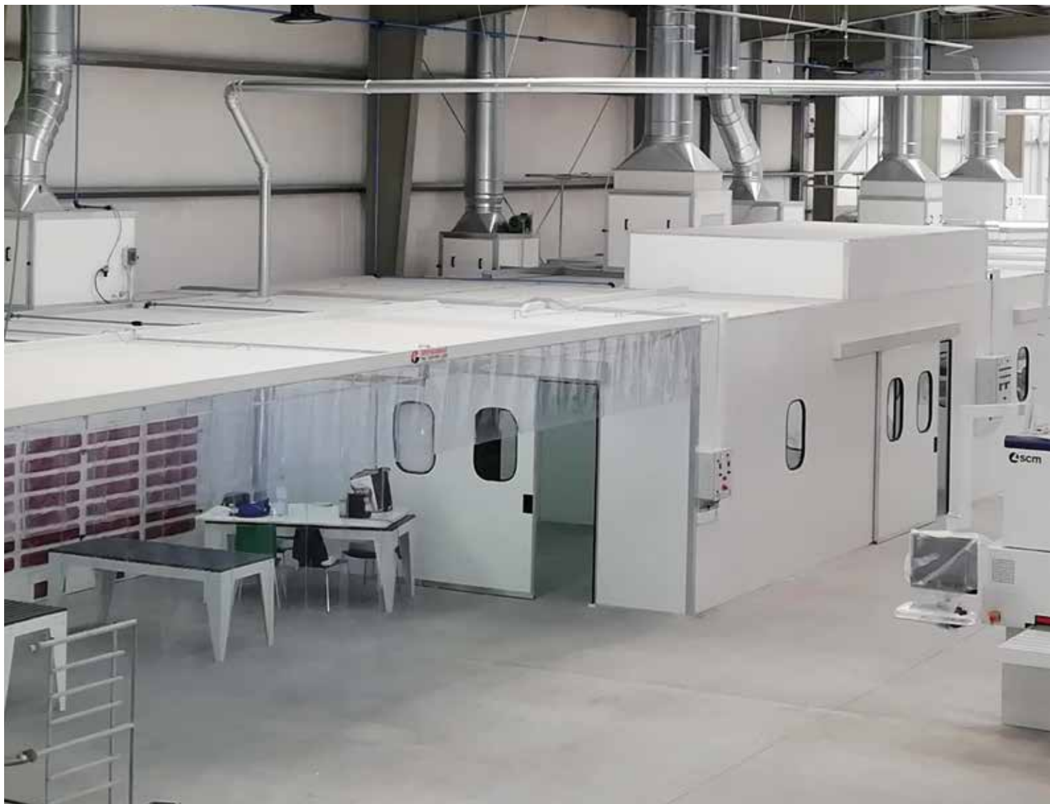
Obra: Sistema de Despoeiramento // Localidade: Sintra // Produtos: Primário Policril Cinzento + Esmalte Policril M/B // Cliente: Ventasel-Ventilações e Aspirações
