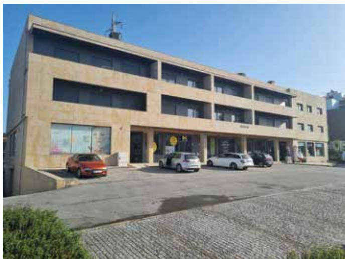
Obra: Prédio Habitacional // Localidade: Ponte de Lima // Produtos: Hidrofugante // Ciente: António Lima Pinto // Comercial: Daniel Gonçalves
