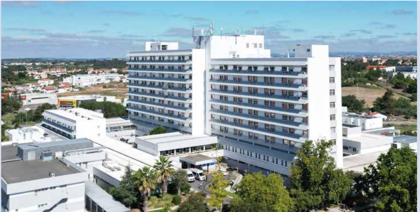
Obra: Hospital de Santarém // Localidade: Santarém // Produtos: Primário Lamurite Aquoso + Lináqua // Cliente: TVM // Aplicador: Unika Radical Comercial: Tiago Medeiros
