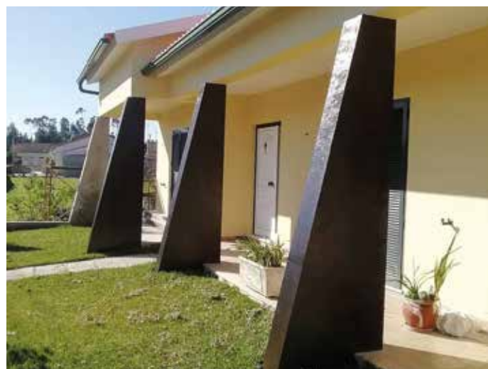
Obra: Moradia Familiar // Localidade: Mira // Produtos: Colunas de betão: Primário Pliomil Aquoso + Verniz Probex Aquoso TD296 Nogueira // Ciente: Carlos Costa // Comercial: Tiago Simões
