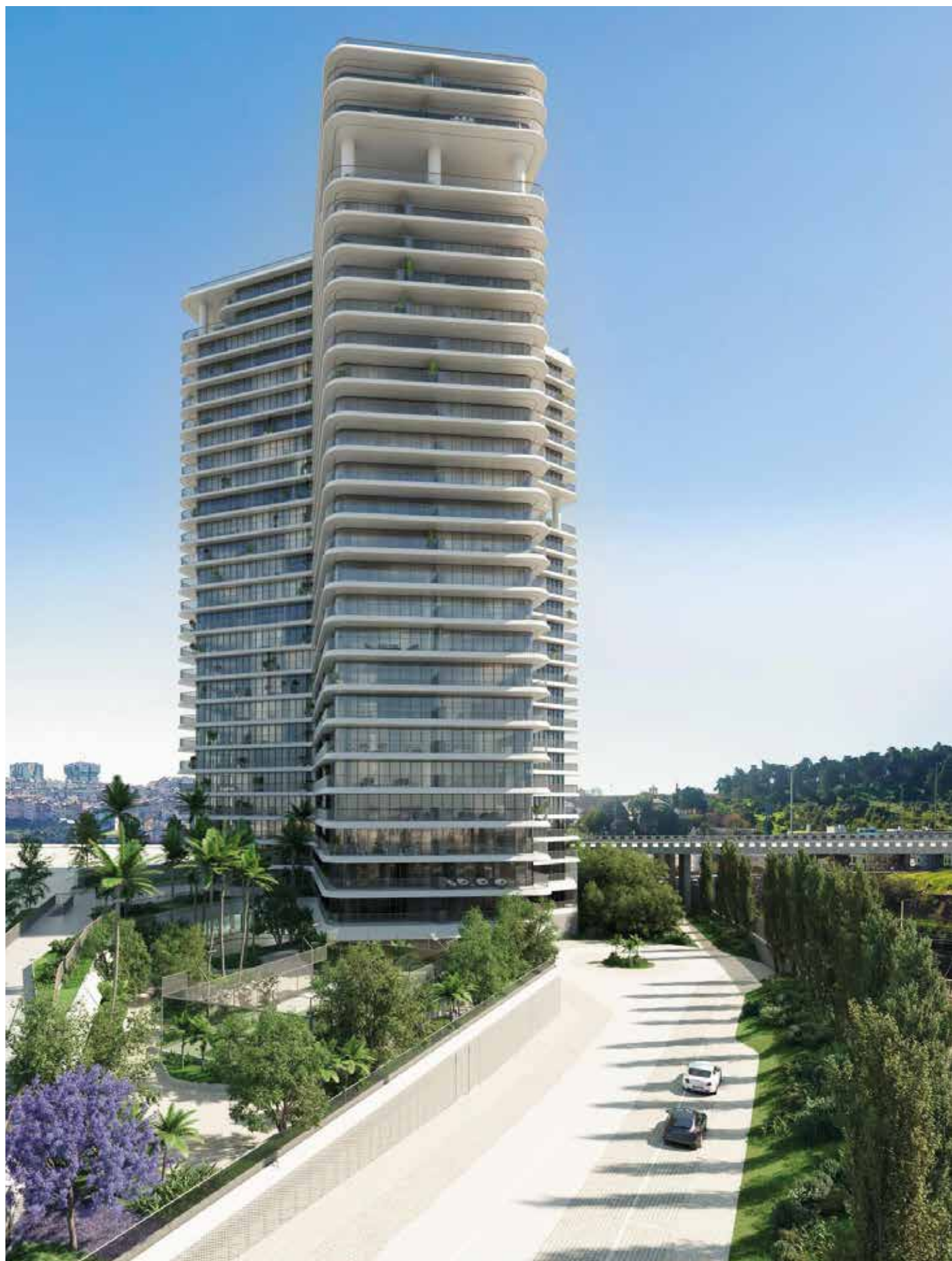
Obra: Infinity Tower // Localidade: Lisboa Produtos: Primário Silicato + Tinta Silicato // Cliente: Mota - Engil // Comercial: Daniel Tocha
