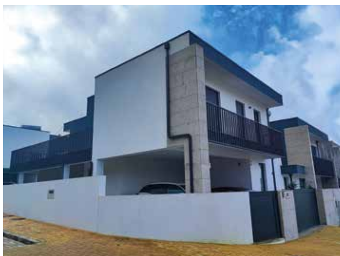
Obra: Moradia Familiar // Localidade: Vila Nova de Famalicão Produtos: Sistema ThermInnov // Ciente: Esquadria & Simetria, Lda. Comercial: Henrique Costa
