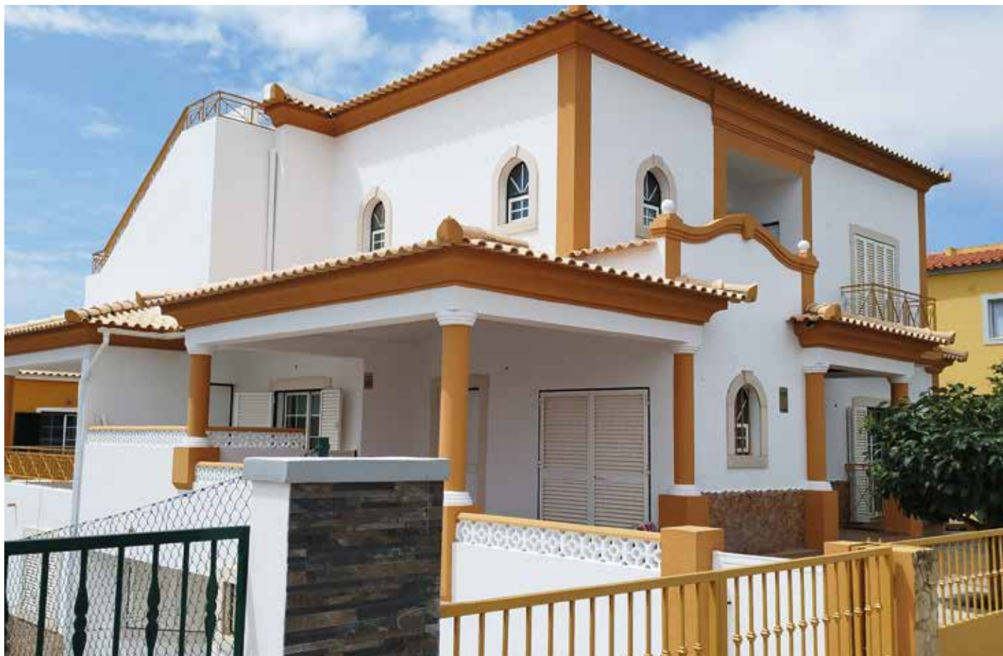
Obra: Moradia Familiar // Localidade: Quelfes - Olhão // Produtos: Produtos de construção civil // Cliente: Vítor Sousa // Comercial: Marco Silva
