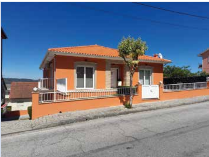
Obra: Moradia Familiar // Localidade: Moimenta da Beira // Produtos: Lináqua S 2050 - Y60R e Branco // Cliente: Plusmate Unipessoal, Lda. Comercial: António Sousa
