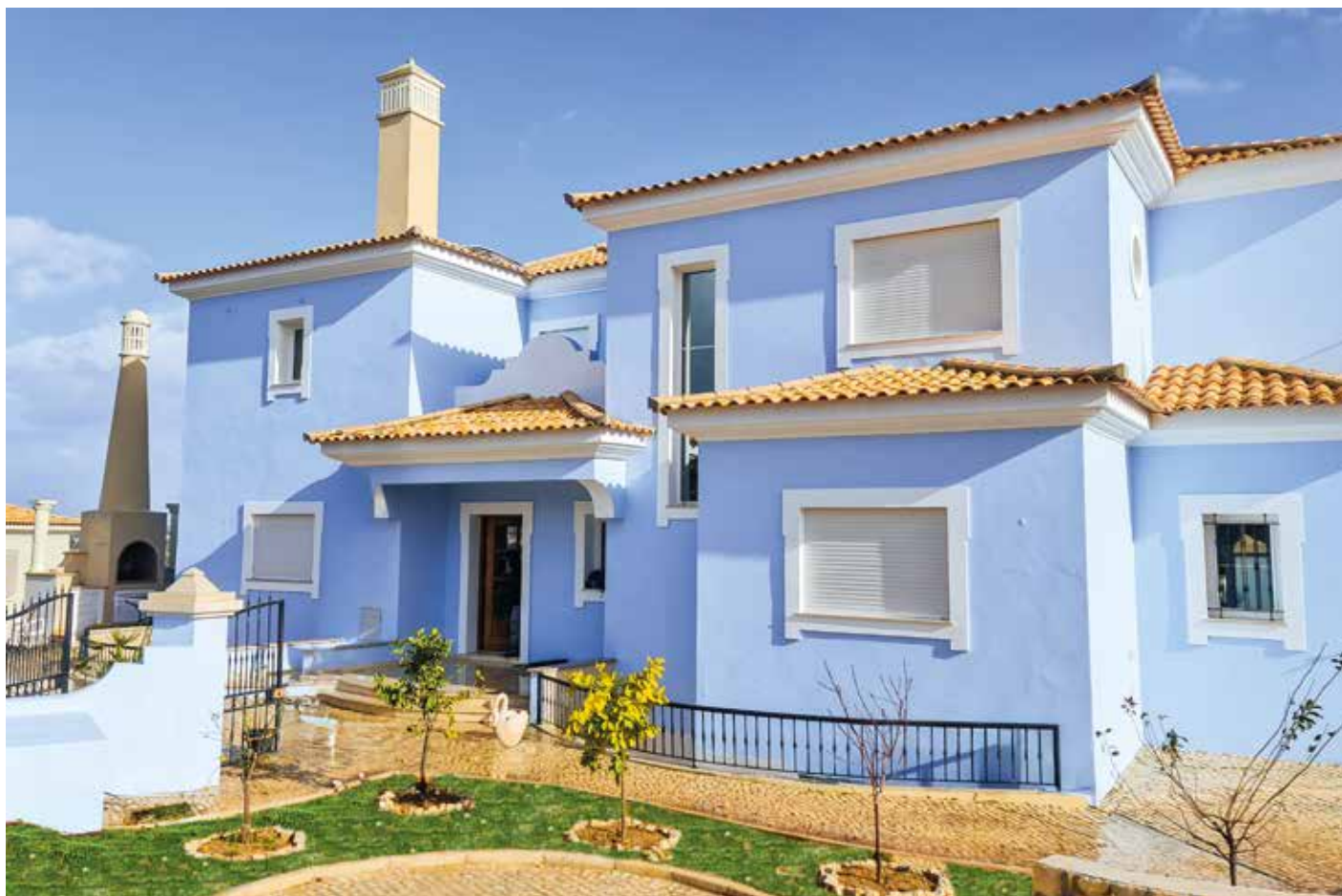
Obra: Moradia Familiar // Localidade: Castro Marim // Produtos: Primário Pliomil Aquoso + Plas Super // Cliente: António dos Anjos // Comercial: João Vieira
