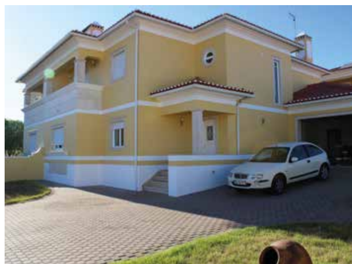
Obra: Moradia Familiar // Localidade: Rio Maior // Produtos: Telhados: Limpamil + Hidrofugante Aquoso Telhas / Fachada: Primário Pliomil + Impermeabilizante Flexível // Ciente: Hélder Lisboa // Comercial: Vitor Neto
