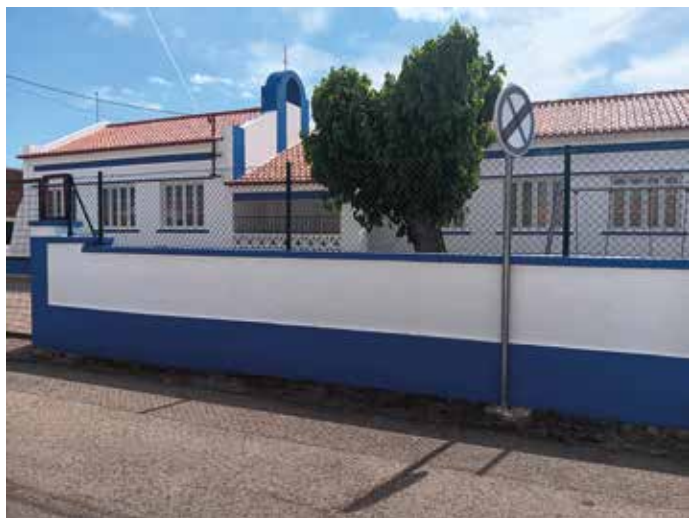
Obra: Escola Primária dos Arcos // Localidade: Estremoz // Produtos: Primário Pliomil Aquoso + Tinta Acrílica Pura 9G // Cliente: José Carlos Curado Falé // Comercial: Vítor Neto
