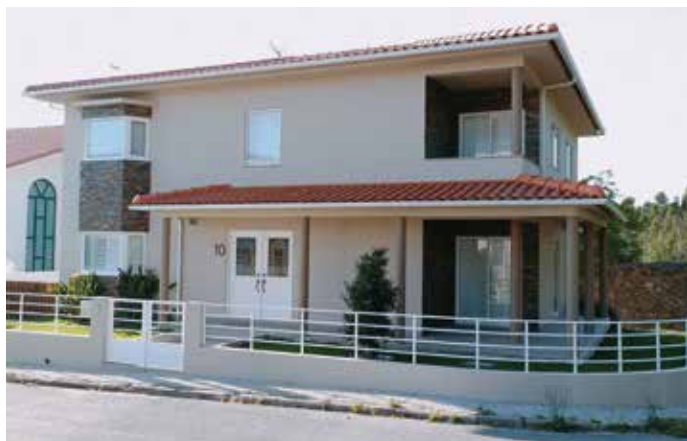
Obra: Moradia Familiar // Localidade: Póvoa de Vazim // Produtos: Telhado: Hidrofugante Aquoso Telhas / Fachada: Primário Lamurite Aquoso + Tinta Acrílica Pura 9G // Cliente: Manuel Azevedo Neto e Eduardo e Miguel, Lda. // Comercial: Carlos Oliveira
