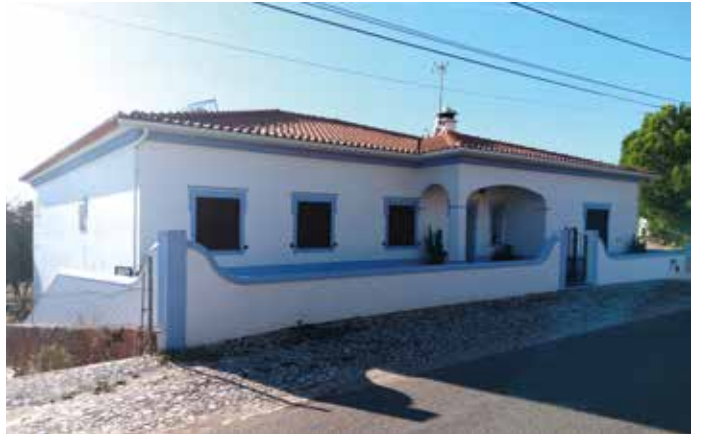
Obra: Moradia Familiar // Localidade: Terena - Alandroal // Produtos: Primário Pliomil Aquoso + Tinta Acrílica Pura 9G // Cliente: Construções Alto de Santiago // Comercial: Vítor Neto
