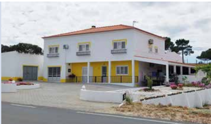
Obra: Moradia Familiar // Localidade: Melides // Produtos: Argamassa ThermInnov + Primário Pliomil Aquoso + Tinta Acrílica Pura 9G // Cliente: Márcio Parreira // Comercial: Pedro Oliveira
