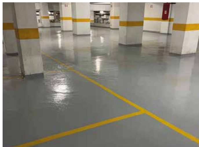
Obra: Pavimento // Localidade: Lumiar - Lisboa // Produtos: Primário EP 2Floor 15-930 + Esmalte PU 2Floor 10-900 // Cliente: George Mindru // Comercial: Luís Alves
