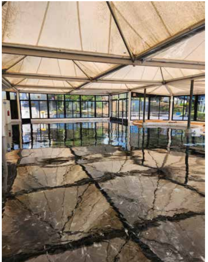
Obra: Pavimento // Localidade: Nazaré // Produtos: Esmalte EP 2Floor 15-910 // Cliente: Resina Best // Comercial: José Oliveira Azevedo
