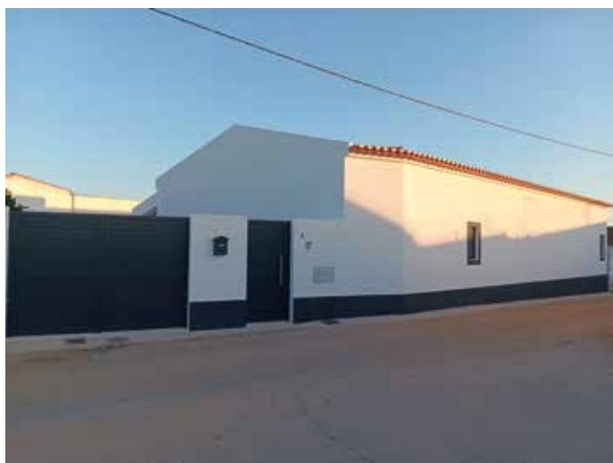
Obra: Moradia Familiar // Localidade: Pedrogão - Moura // Produtos: Sistema ThermInnov // Cliente: José Navalhinhas // Comercial: Vítor Neto
