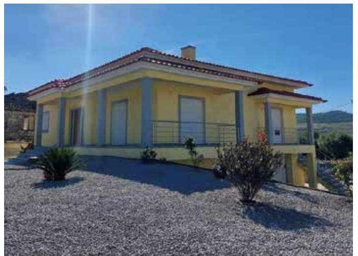
Obra: Moradia Familiar // Localidade: Almeidinha - Mangualde // Produtos: Primário Isolina + Lináqua // Ciente: Fernando Andrade Ribeiro // Comercial: Luís Almeida
