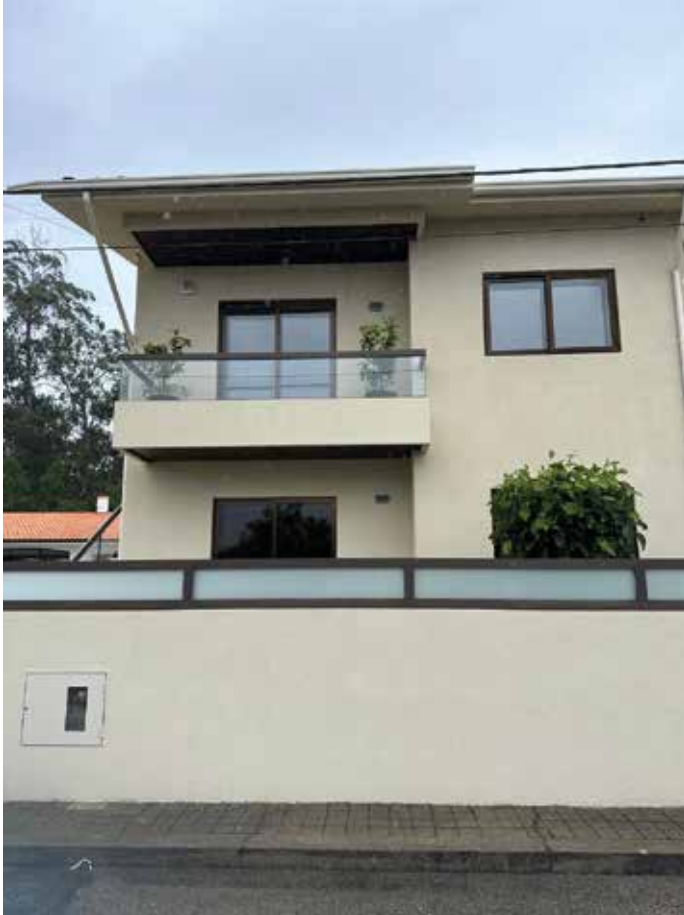
Obra: Moradia Familiar // Localidade: Vila Nova de Gaia // Produtos: Sistema Thermlnnov // Ciente: Bruno Leandro Revestimentos // Comercial: Hugo Figueiredo
