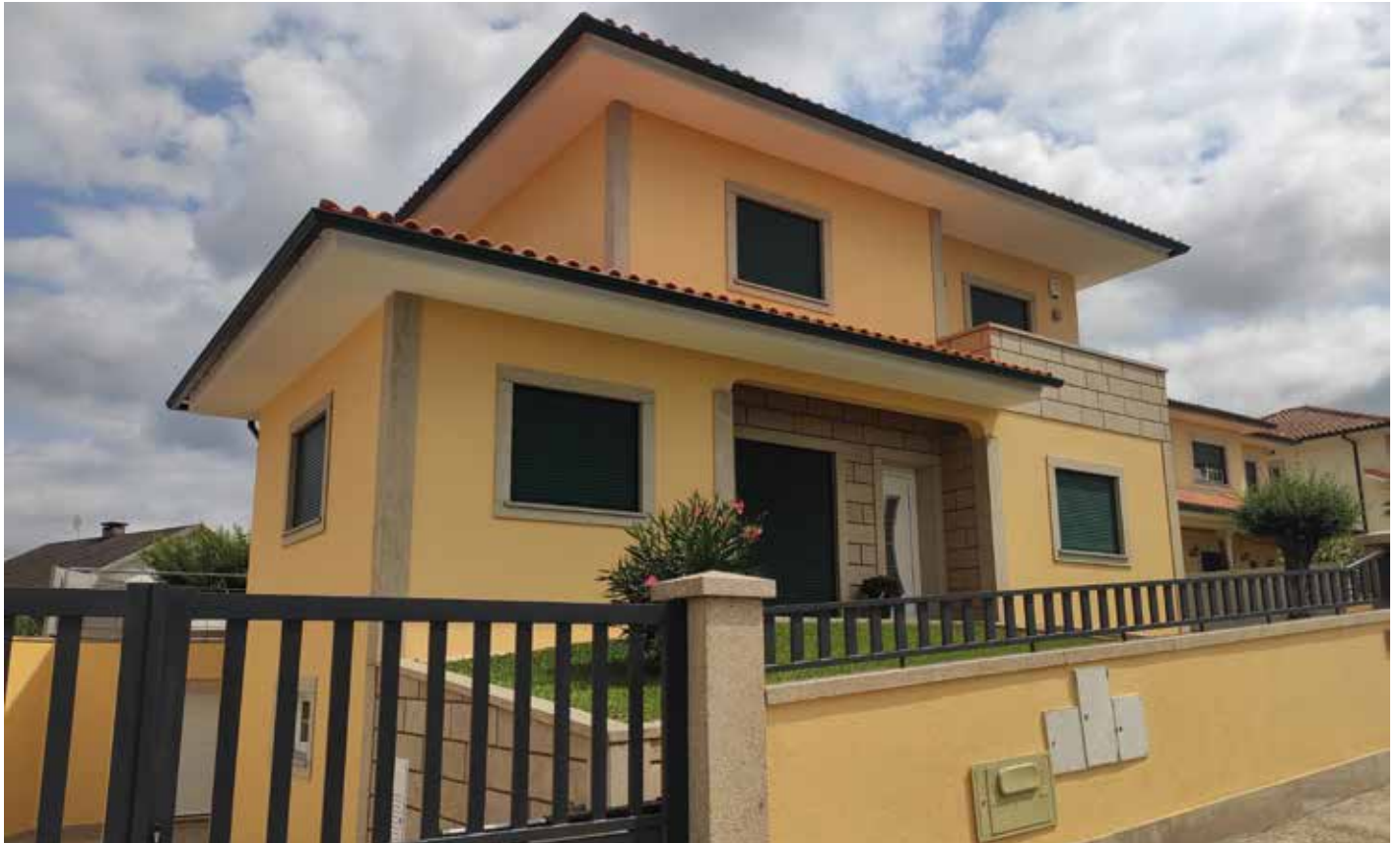
Obra: Moradia Familiar // Localidade: Monção // Produtos: Fachada: Primário Lamurite Aquoso + Elastoflex / Varandas e Cornijas: Niloplaste Branco Gradeamentos e Portões: Primário Anticorrosivo Cinzento + Esmalte Nilaite Cinza // Ciente: José Adriano Brito Gomes // Comercial: Carlos Oliveira
