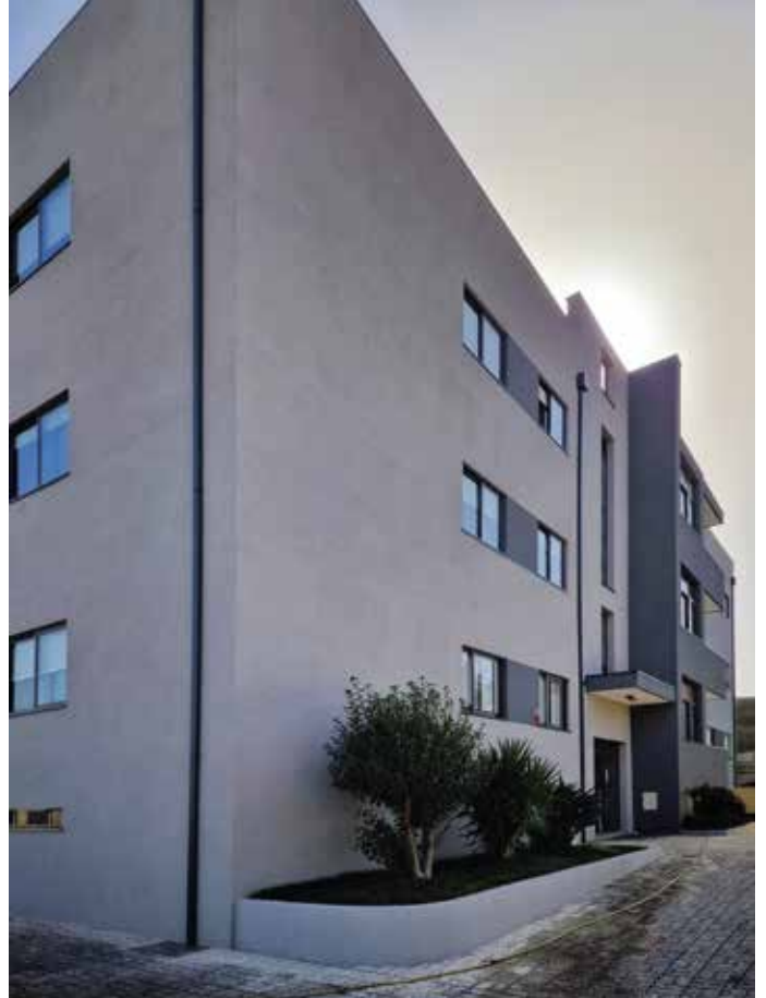
Obra: Prédio Habitacional // Localidade: Ermesinde - Porto // Produtos: Sistema ThermInnov // Cliente: Robustogabarito // Comercial: Carlos Lopes
