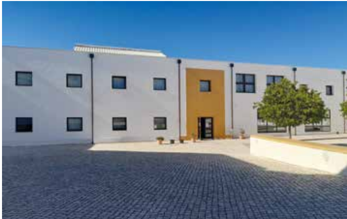
Obra: Escola Manuel Ferreira Patrício // Localidade: Évora // Produtos: Primário Pliomil Aquoso + Plas Super // Cliente: António Cambeiro Comercial: Vítor Neto
