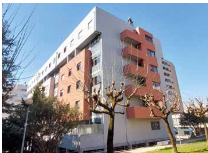
Obra: Prédio Habitacional // Localidade: Braga // Produtos: Sistema ThermInnov // Cliente: José Miguel Veloso Unipessoal, Lda. Comercial: Henrique Costa
