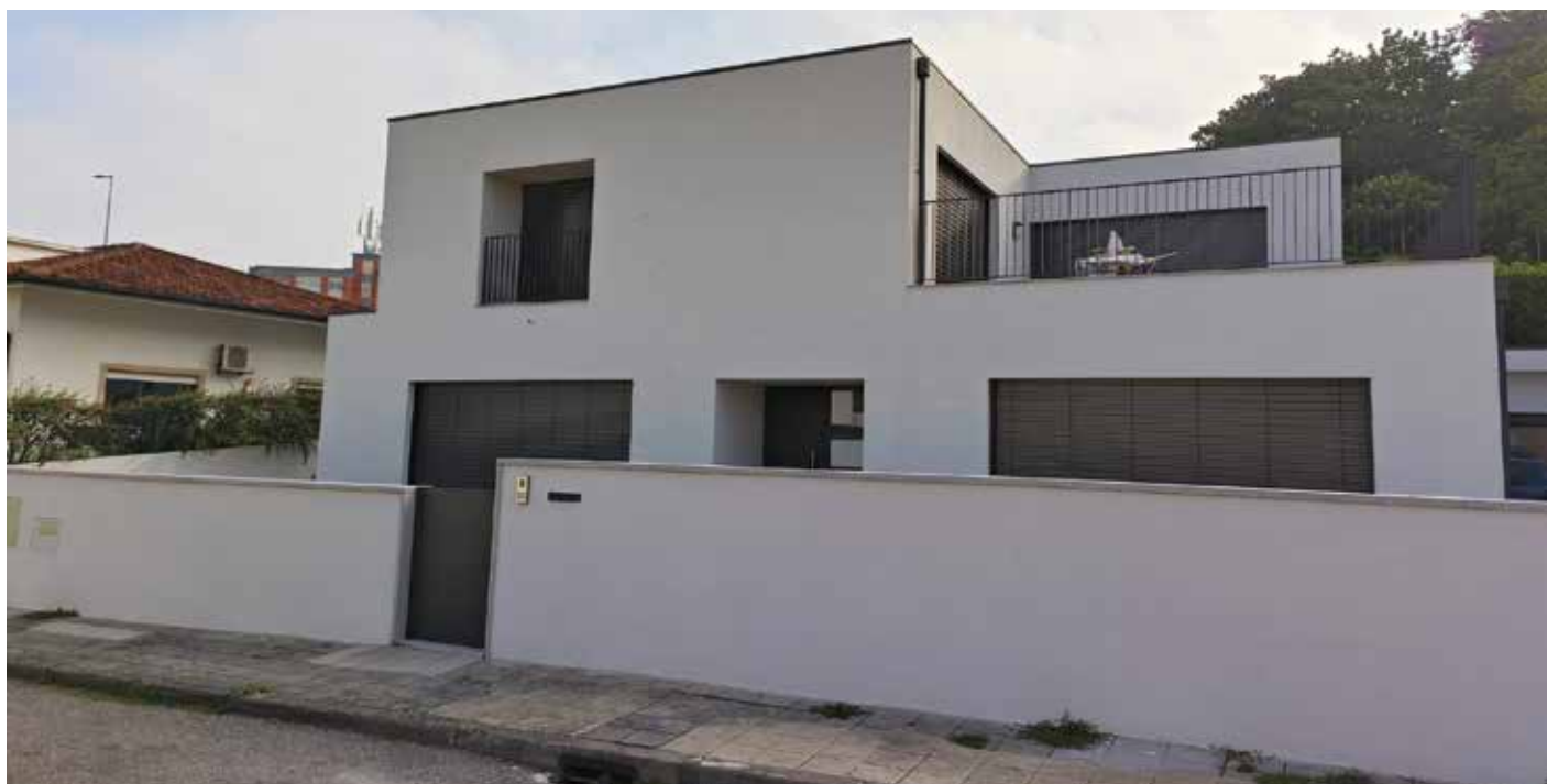
Obra: Moradia Familiar // Localidade: Santo Tirso // Produtos: Fachada: Sistema ThermInnov / Interior: Primário Isolina + Linamate // Cliente: Ribeiro da Silva, Lda. // Comercial: Carlos Oliveira
