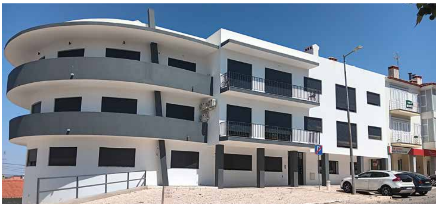
Obra: Prédio Habitacional // Localidade: Borba // Produtos: Primário Isoselante Texturado + Tinta Acrílica AD // Cliente: Hélder Azeitona // Comercial: Vítor Neto
