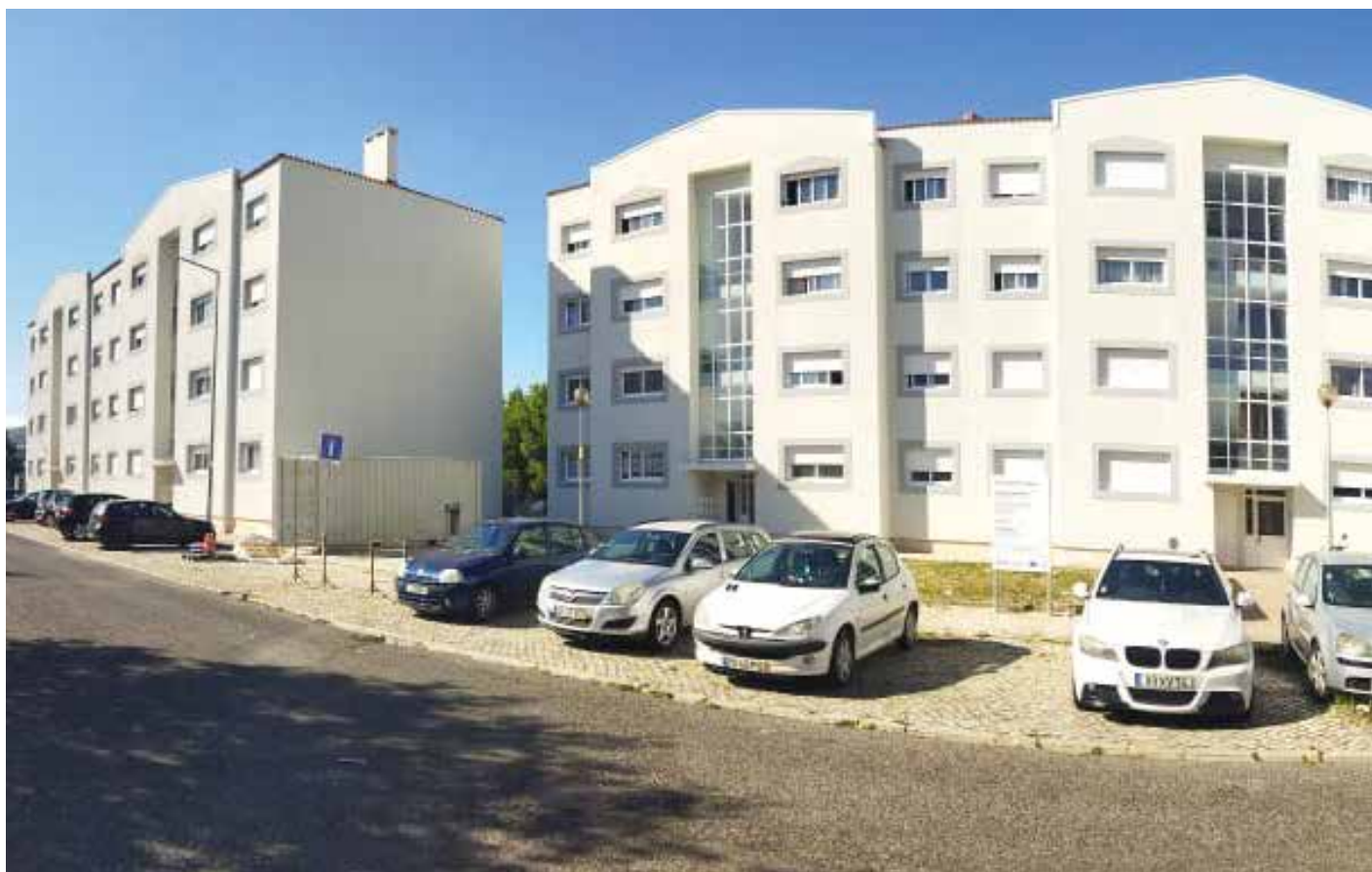
Obra: Bairro da Cruz Vermelha // Localidade: Cascais // Produtos: Sistema ThermInnov + Niloplaste // Ciente: Planeta Salteado // Comercial: Luís Alves
