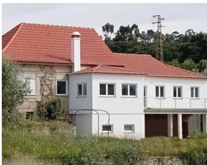
Obra: Moradia Familiar // Localidade: Contenças de Baixo - Mangualde Produtos: Telhados: Limpalina + Hidrofugante Aquoso Telhas / Fachada: Sistema ThermInnov // Ciente: Ricardo Inácio // Comercial: Luís Almeida
