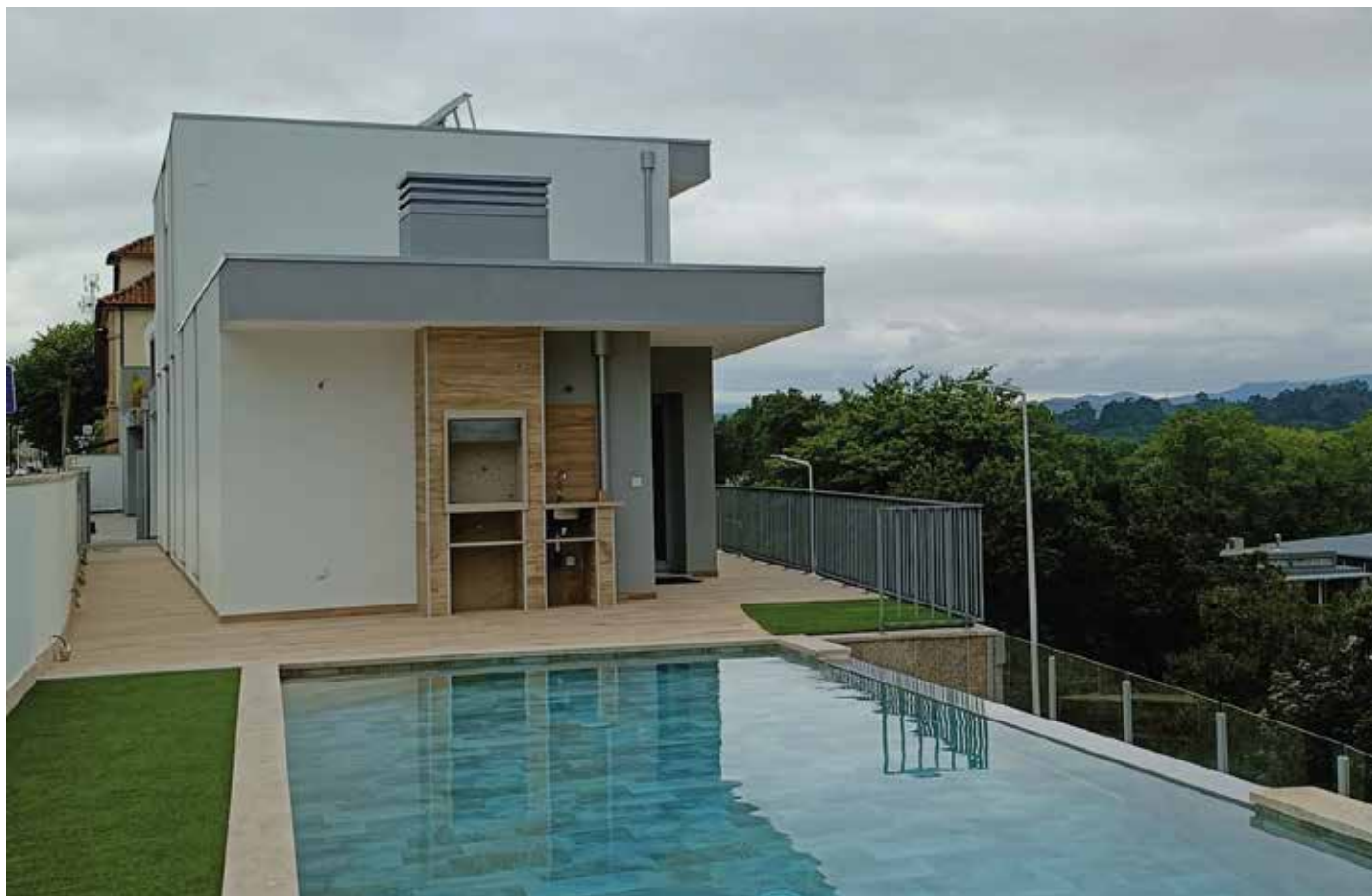
Obra: Alojamento Local // Localidade: Monção // Produtos: Muros: Primário Lamurite Aquoso Branco + Tinta Acrílica Pura 9G / Fachada: Primário Lamurite Aquoso + Crepimil Extra + Tinta Acrílica Pura 9G // Ciente: José Alberto Afonso Campos // Comercial: Carlos Oliveira
