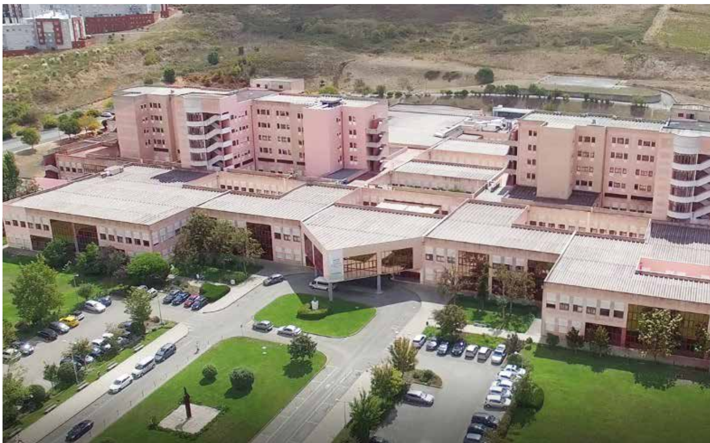
Obra: Hospital Amadora - Sintra // Localidade: Amadora // Produtos: Primário Lamurite PL + Tinta Acrílica Pura 9G // Cliente: Azul Comum // Comercial: Domingos Galante
