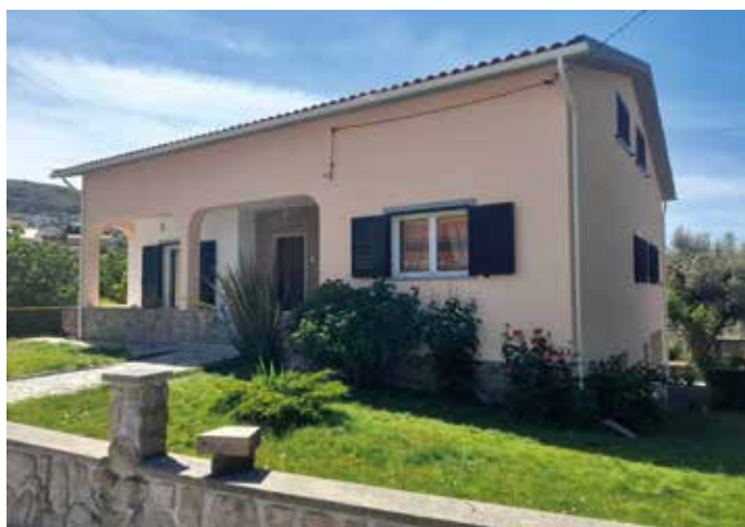
Obra: Moradia Familiar // Localidade: Aldeia Nova - Trancoso // Produtos: Primário Lamurite Aquoso + Linatex TD7492 Cinza Ciclone e TD586 Damasco // Ciente: Maximiano & Pires, Lda. // Comercial: António Sousa
