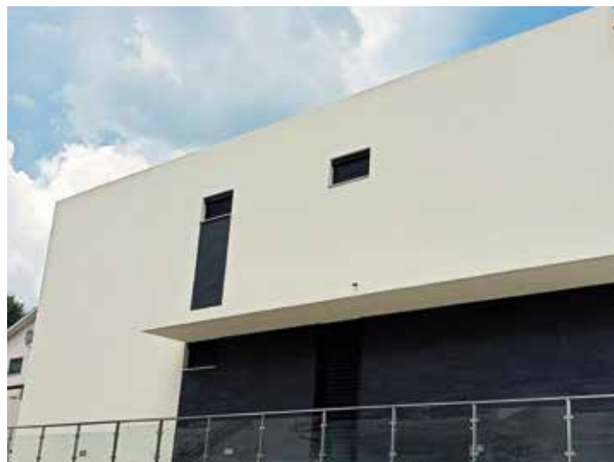
Obra: Moradia Familiar // Localidade: Vila Real // Produtos: Sistema ThermInnov // Ciente: Determina Sempre, Lda. / Domus 3000 // Comercial: Loja de Vila Real
