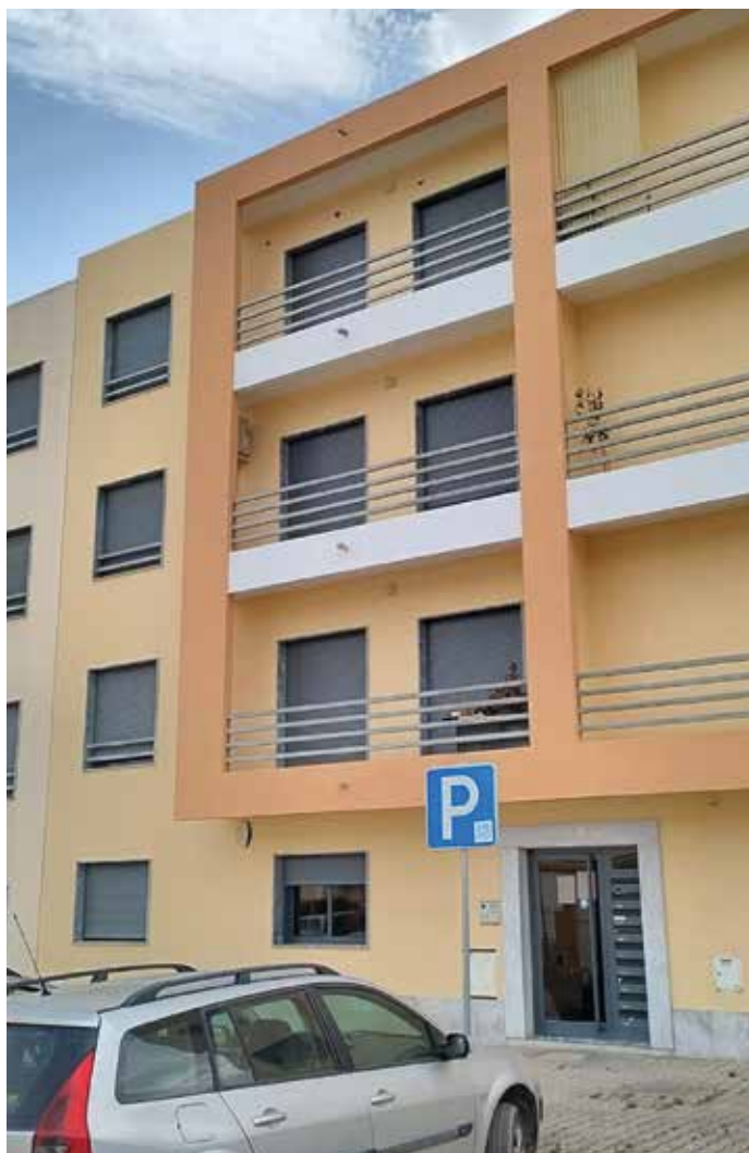
Obra: Prédio Habitacional // Localidade: Grândola // Produtos: Primário Pliomil Aquoso + Tinta Acrílica AD // Cliente: Valsa das Cores // Comercial: Pedro Oliveira
