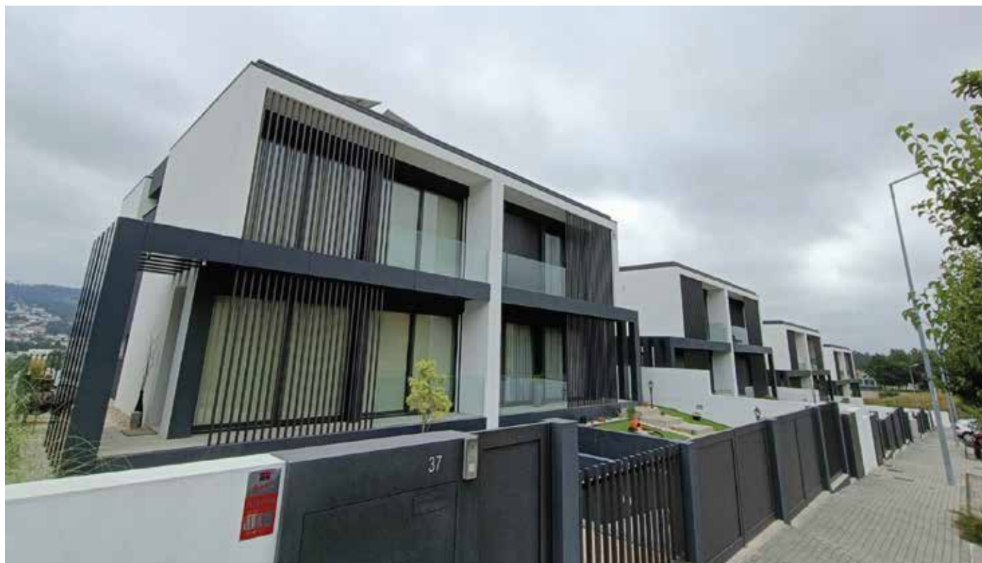
Obra: Moradias Familiares - Urbanização de Cornide // Localidade: Joane - Vila Nova de Famalicão // Produtos: Sistema ThermInnov + Tinta Acrílica Pura 9G // Ciente: Ribeiro da Silva, Lda. // Comercial: Carlos Oliveira
