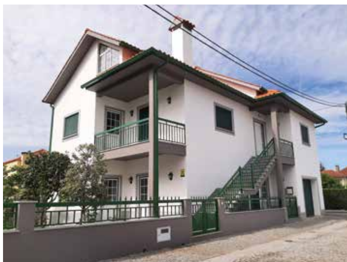
Obra: Moradia Familiar // Localidade: Tondela // Produtos: Telhado: Limpamil + Hidrofugante / Fachada: Primário Pliomil Aquoso + Impermeabilizante Flexível / Gradeamentos: Esmalte Maital // Ciente: Carlos Alberto Coimbra Figueiredo // Comercial: Armando Almeida
