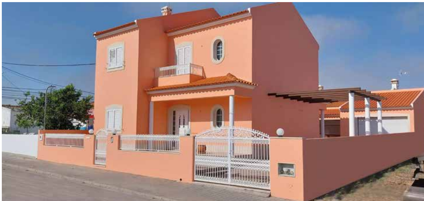
Obra: Moradia Familiar // Localidade: Carvalhal - Comporta // Produtos: Primário Pliomil Aquoso + Tinta Acrílica Pura 9G Branco e TD576 Salmão // Cliente: Márcio Parreira // Comercial: Pedro Oliveira
