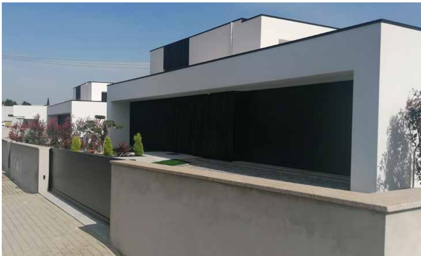
Obra: Moradias Familiares // Localidade: Gondar - Guimarães // Produtos: Sistema ThermInnov // Cliente: Nível Narrativo, Lda. // Comercial: Tiago Fernandes
