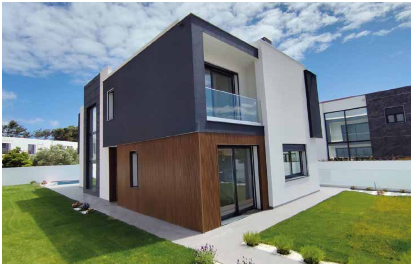
Obra: Moradia Familiar // Localidade: Birre - Cascais // Produtos: Sistema ThermInnov // Cliente: Horácio Boaventura // Comercial: Rodrigo Caseiro
