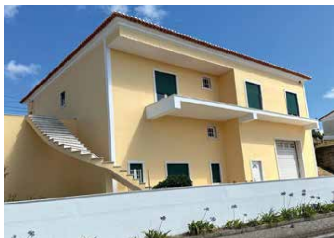
Obra: Moradia Familiar // Localidade: Colarias - Torres Vedras // Produtos: Telhados: Limpalina + Hidrofugante Aquoso Telhas / Fachada: Primário Lamurite Aquoso + Tinta Acrílica Pura 9G / Muro: Lináqua // Cliente: Freiripinta, Lda. // Comercial: Luís Alves
