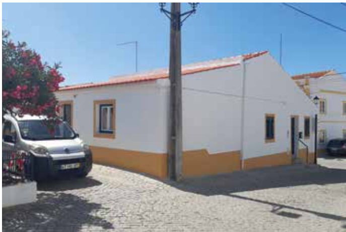
Obra: Moradia Familiar // Localidade: Monte do Trigo - Portel // Produtos: Primário Pliomil Aquoso + Plas Super // Cliente: Cláudio Rodrigues Comercial: Vítor Neto
