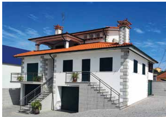
Obra: Moradia Familiar // Localidade: Vila Nova de Famalicão Produtos: Sistema ThermInnov // Ciente: Joaquim Sá // Comercial: Henrique Costa
