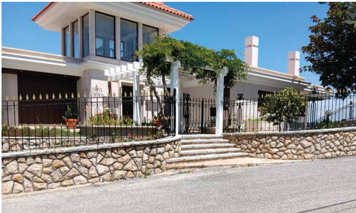
Obra: Moradia Familiar // Localidade: Cabeça Gorda - Abrantes // Produtos: Telhado: Limpalina + Hidrofugante Aquoso Telhas / Fachada: Primário Lamurite PL e Lamurite Aquoso / Gradeamentos: Esmalte Linauto Branco // Ciente: Joaquim Lopes // Comercial: José Conde
