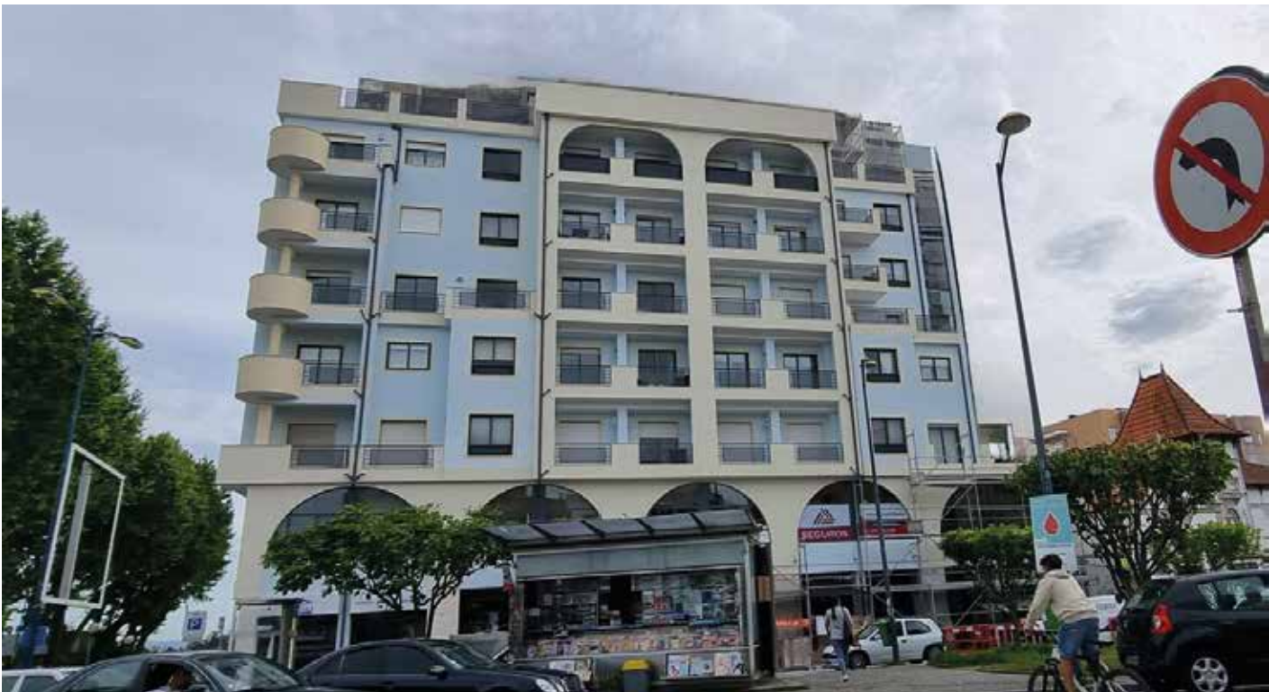
Obra: Prédio Habitacional // Localidade: Largo de Santo António - Gondomar // Produtos: Sistema ThermInnov // Cliente: Momento Fletor // Comercial: Domingos Galante
