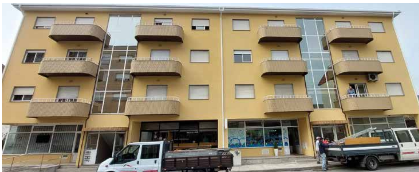
Obra: Prédio Habitacional // Localidade: Joane - Vila Nova de Famalicão // Produtos: Sistema ThermInnov // Cliente: José Miguel Veloso Unipessoal, Lda. // Comercial: Henrique Costa
