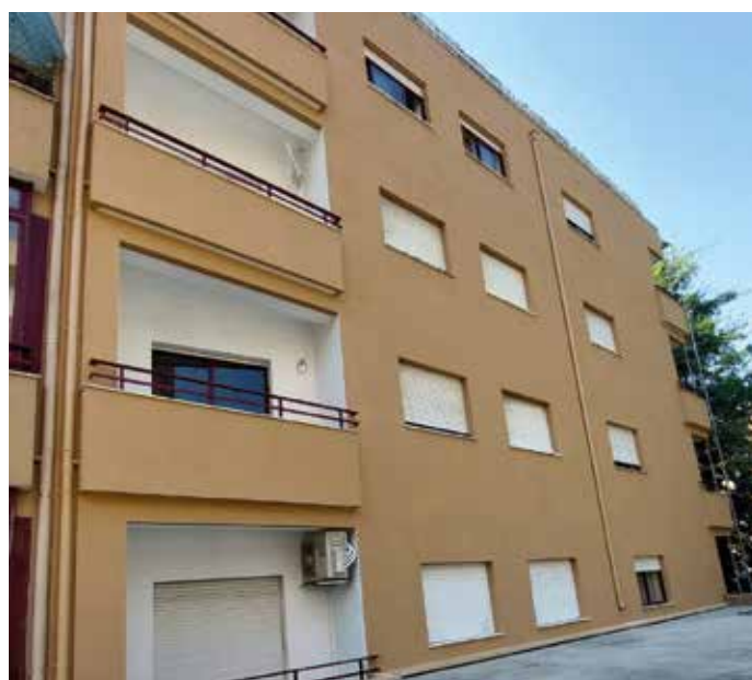
Obra: Prédio Habitacional // Localidade: Braga // Produtos: Sistema ThermInnov // Cliente: José Miguel Veloso Unipessoal, Lda. // Comercial: Henrique Costa
