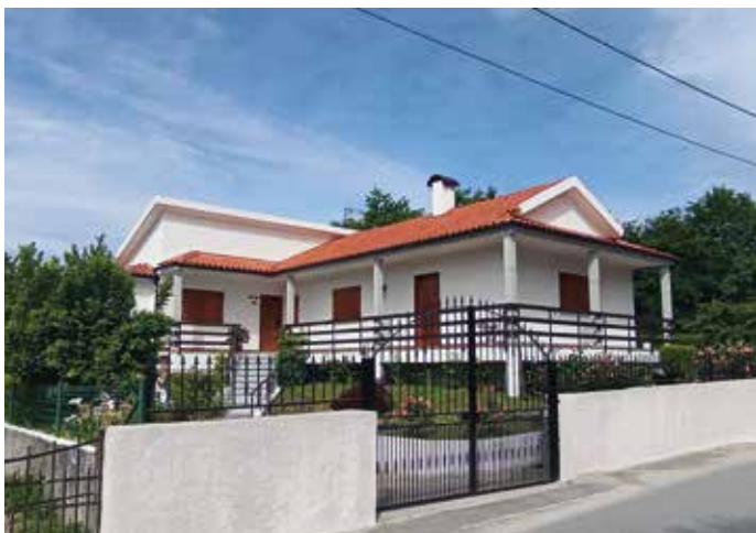
Obra: Moradia Familiar // Localidade: Contenças de Baixo - Mangualde // Produtos: Telhados: Limpalina + Hidrofugante Aquoso Telhas / Fachada: Primário Lamurite PL + Elastoflex / Gradeamentos: Esmalte Ferrolina / Madeiras: Verniz Probex // Ciente: Luís Morgado // Comercial: Luís Almeida
