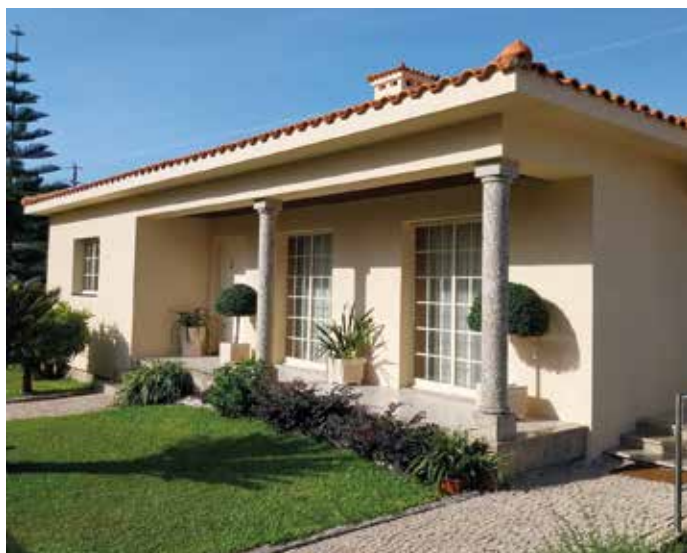
Obra: Moradia Familiar // Localidade: Fafe // Produtos: Sistema ThermInnov // Ciente: Eurico Nogueira, Unipessoal. Lda. // Comercial: Henrique Costa
