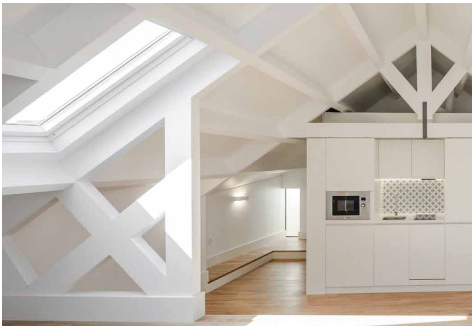
Obra: Estruturas de Madeira e Cozinha // Localidade: Grijó - Vila Nova de Gaia // Produtos: Subcapa PU TIX + Esmalte Lacamil Mate // Cliente: Carpintaria da Lavandeira
