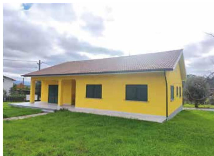
Obra: Moradia Familiar // Localidade: Contenções de Baixo - Mangualde Produtos: Primário Isolina + Silicaflex // Cliente: Arlindo Silva Rodrigues Comercial: Luís Almeida
