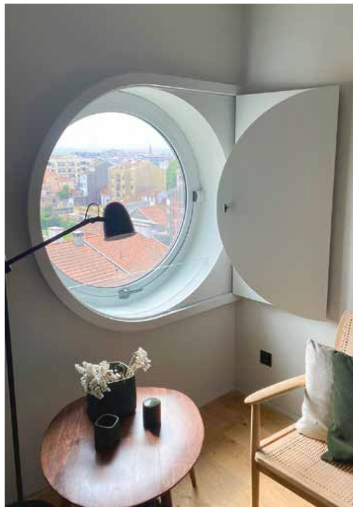
Obra: Janela // Localidade: Grijó - Vila Nova de Gaia // Produtos: Subcapa PU TIX + Esmalte Lacamil Mate // Cliente: Carpintaria da Lavadeira // Comercial: Hélder Oliveira
