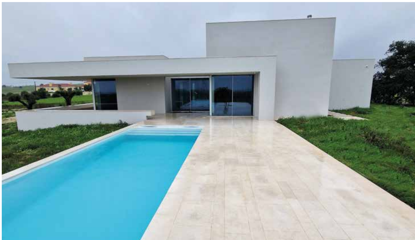
Obra: Moradia Familiar // Localidade: Santarém // Produtos: Fachada: Sistema ThermInnov / Interior: Primário Isolina + Linamate // Ciente: Saldanha e Alves Comercial: Daniel Tocha
