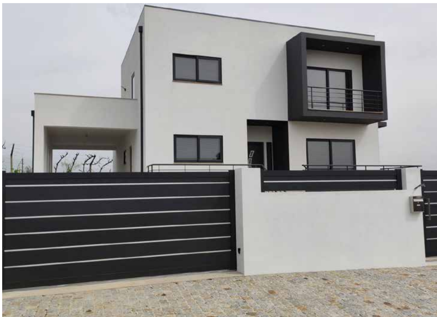
Obra: Moradia Familiar // Localidade: Cete - Paredes // Produtos: Fachada: Primário Pliomil Aquoso + Tinta Acrílica Pura 9G / Interior: Primário Isoselante + Plastec Branco // Ciente: Lisandro Barbosa Unipessoal // Comercial: João Ribeiro
