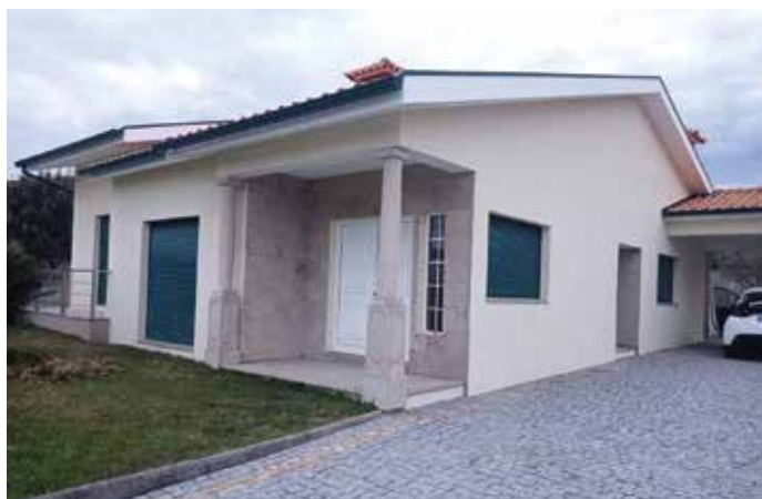
Obra: Moradia Familiar // Localidade: Oliveira Santa Maria - Vila Nova de Famalicão // Produtos: Sistema ThermInnov // Ciente: Hélder M. S. Santos, Unipessoal. Lda. // Comercial: Henrique Costa
