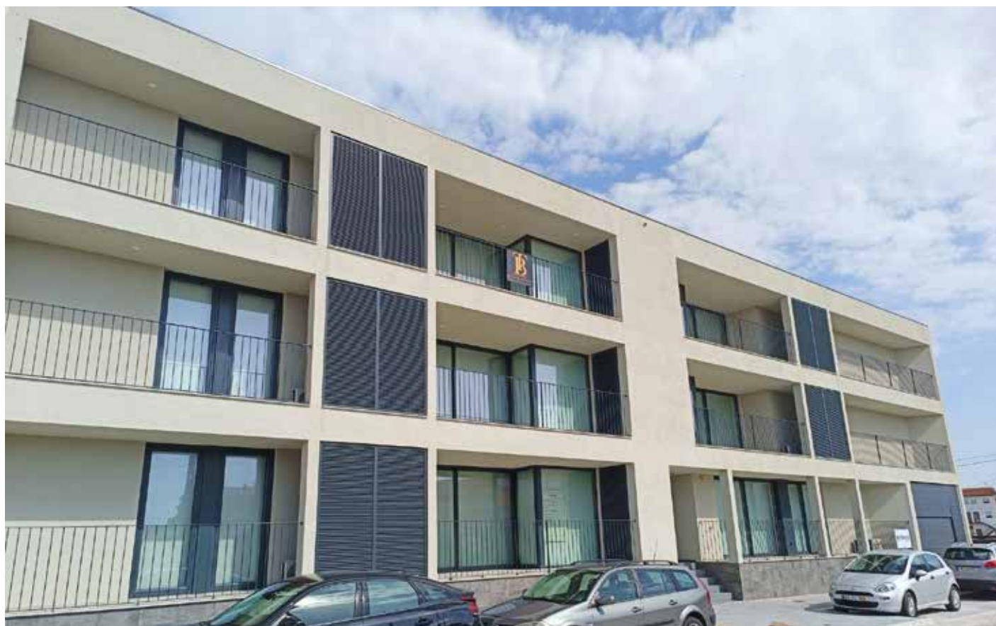
Obra: Prédio Habitacional // Localidade: Apúlia - Esposende // Produtos: Sistema ThermInnov // Cliente: Partisólido - Construção Civil, Lda. Comercial: Carlos Oliveira
