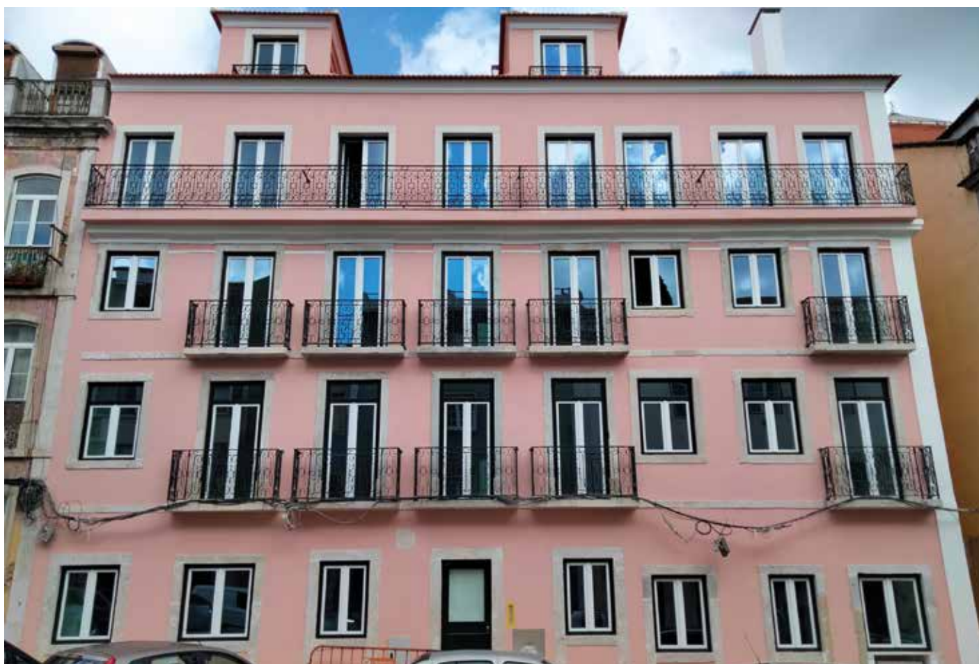
Obra: Prédio Habitacional // Localidade: Lisboa // Produtos: Sistema ThermInnov // Cliente: Horácio Boaventura // Comercial: Rodrigo Caseiro
