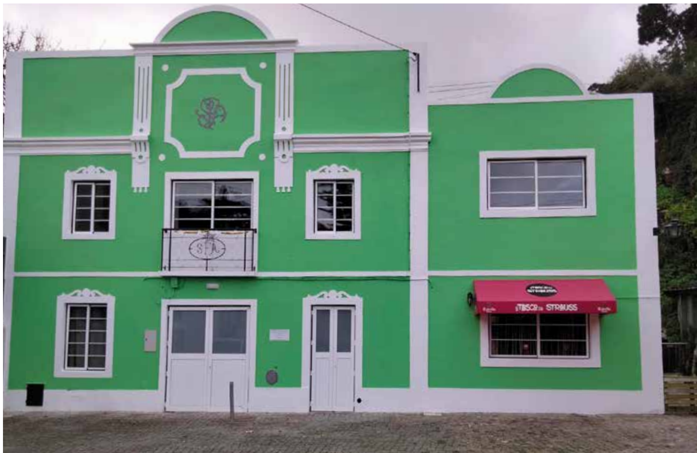
Obra: Sociedade Filarmónica Os Aliados - S. Pedro de Penaferrim // Localidade: Sintra // Produtos: Fachada: Solução Anti Fungos + Isolante Betonilha + Argamassa ThermInnov 2009 Cinza + Elastoflex + Esmalte Ferrolina // Ciente: Rolstar // Comercial: Rodrigo Caseiro
