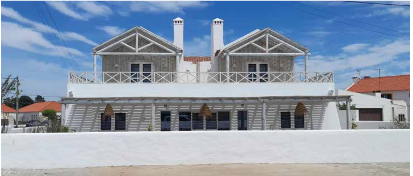
Obra: Moradia Familiar // Localidade: Comporta // Produtos: Fachada: Argamassa ThermInnov + Isolante Betonilha + Primário Pliomil Aquoso + Tinta Acrílica Pura 9G Branca / Interior: Primário Pliomil Aquoso + Plastec Branco // Cliente: Empisul e Habi-Santiago // Comercial: Pedro Oliveira
