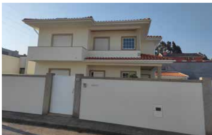
Obra: Moradia Familiar // Localidade: Vila das Aves - Vila do Conde // Produtos: Sistema ThermInnov // Cliente: Topifer - Construtores Cívicos, Lda. // Comercial: Carlos Oliveira
