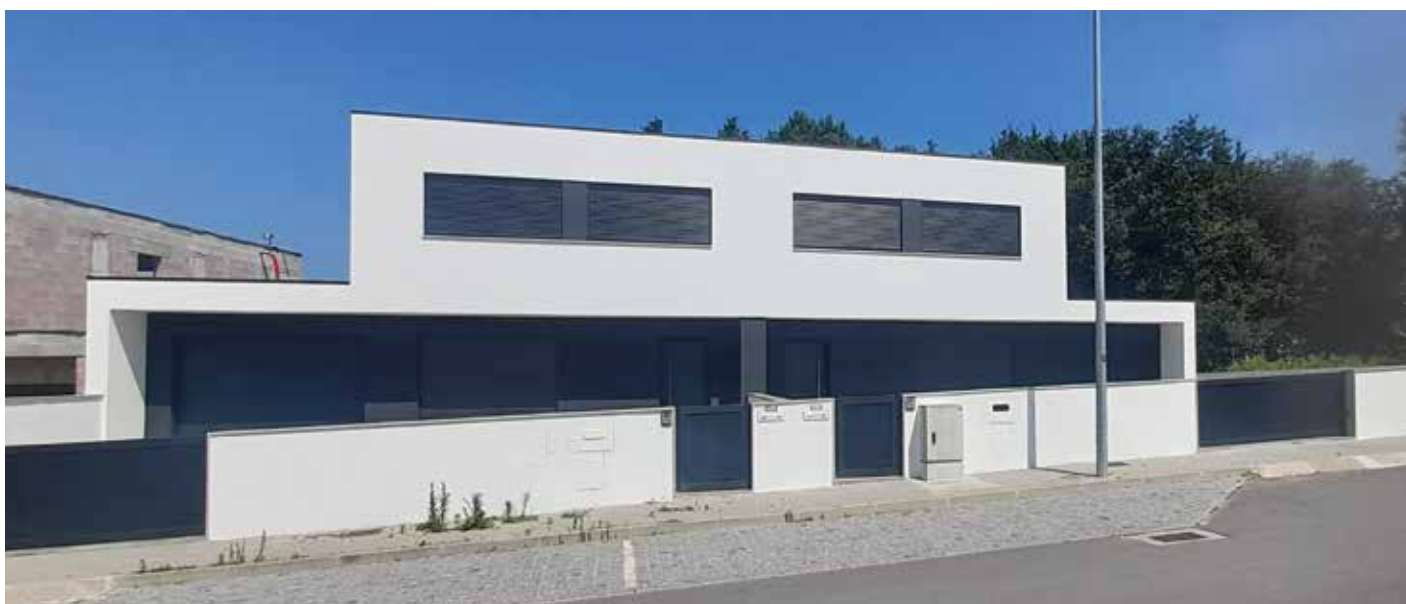
Obra: Moradia Familiar // Localidade: Caldas das Taipas - Guimarães // Produtos: Primário Isolina + Crepimil Extra R12 + Tinta Acrílica Pura 9G // Cliente: Laura Maria Silva Vieira // Comercial: Paulo Gomes
